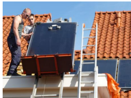
Plaatsen zonneboiler bij een werkgroepslid
